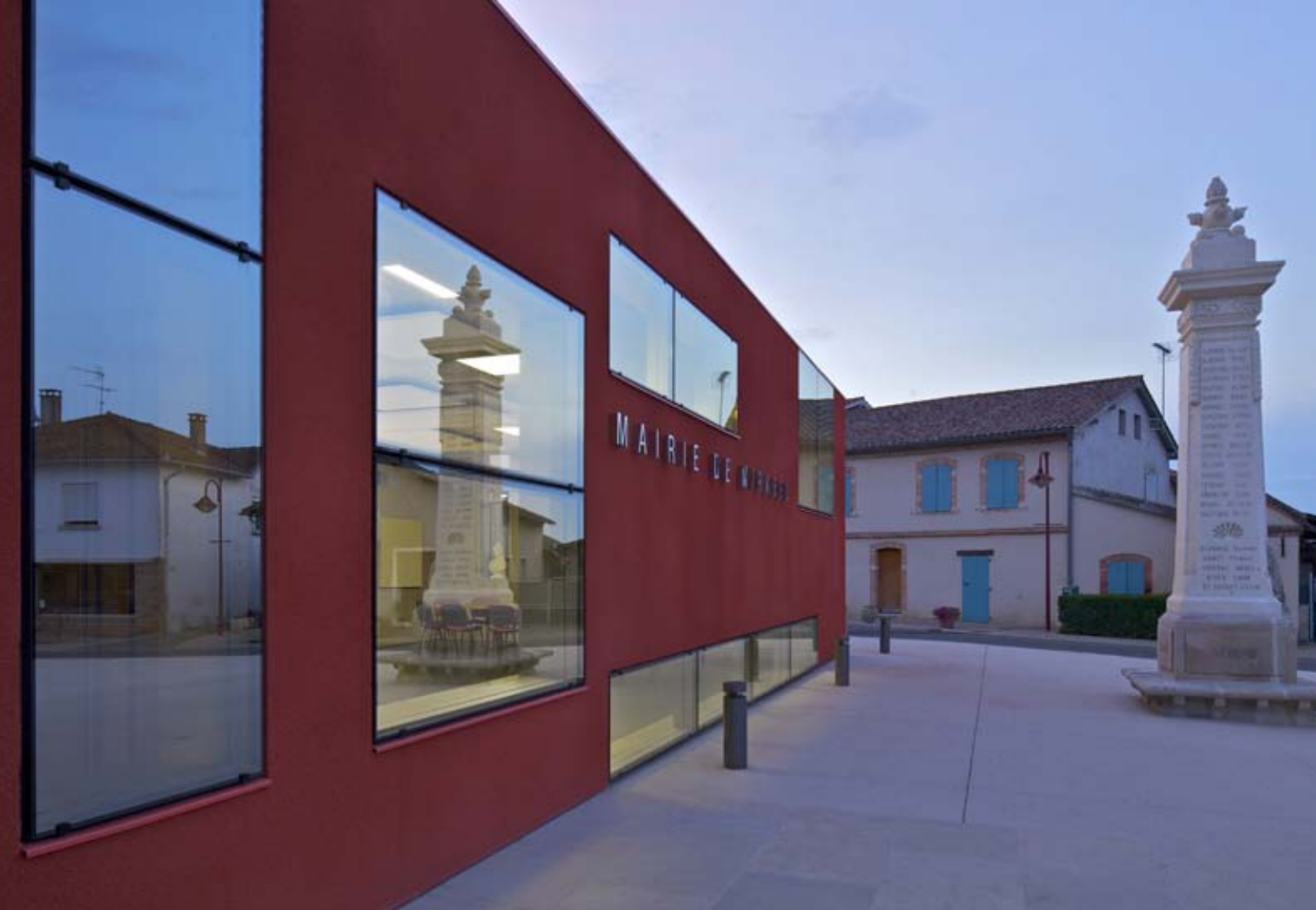
Jeux de reflets entre le monuments aux morts et les vitrages de la mairie (crédit photo : Philippe Ruault)
