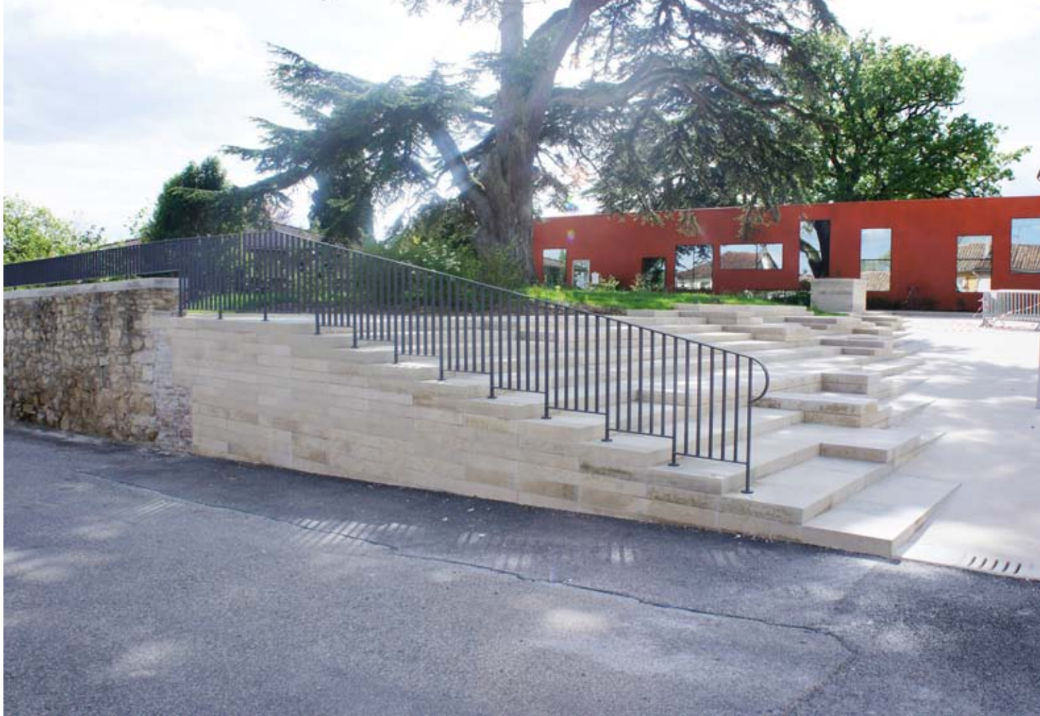
Face latérale de l'emmarchement, le raccordement avec le mur existant (crédit photo : Rémy Turquin)
